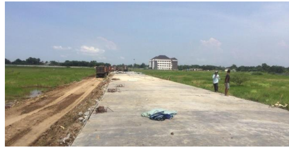
Gambar 3. 32 Pembangunan Jalan di Kampus II Unsika
