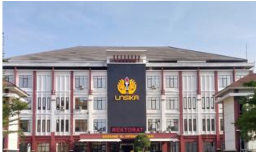
Gambar 1: Gedung Rektorat UNSIKA
